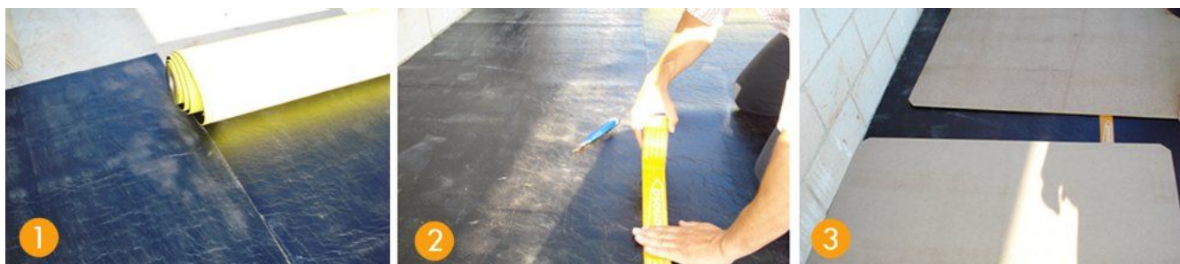
Extender. Sellar solape. Colocar suelo flotante seco.
