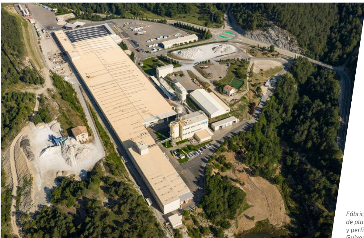
Fábrica Knauf de placa de yeso, perfilera, pastas y enlucidos en Escúzar, Granada.
